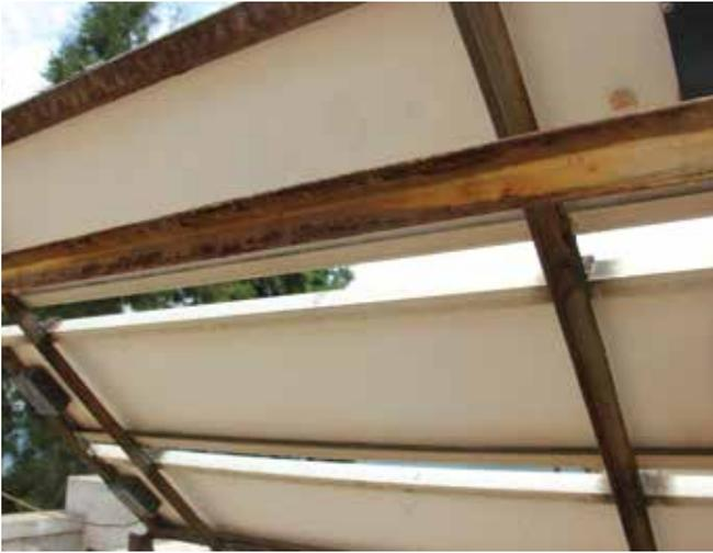
在户外近20年后，支架已见锈迹斑斑，但基于杜邦™ 特能® PVF薄膜的背板外观无明显变化。经检测，黄度b\*值变化仅为1.6-1.8，表明其优异的耐候性。
