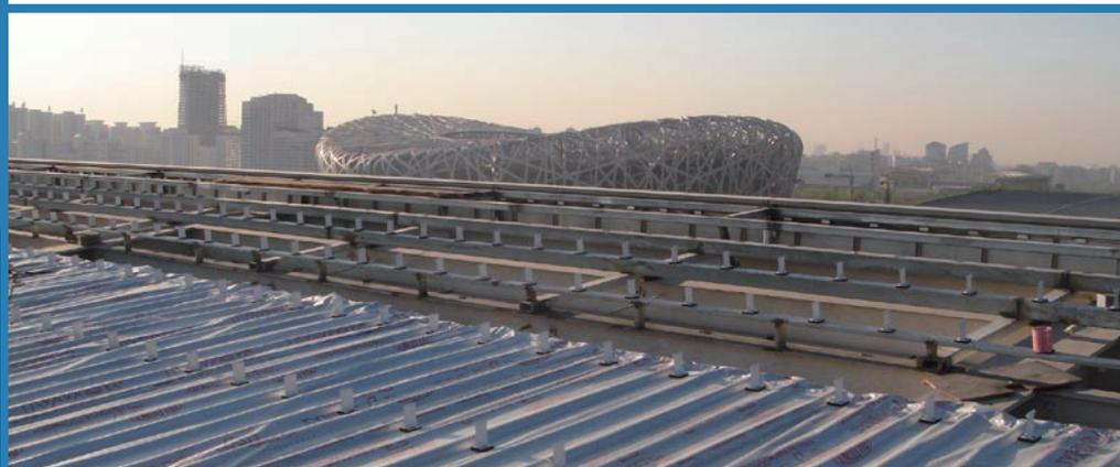
随着2008北京奥运的日趋临近，各大奥运场馆的工程建设也正如火如荼地进行着。这其中，杜邦公司关于建筑要具有呼吸性的新型节能观点得到有关专家和主管部门的一致认同。国家会议中心5万m<sup>2</sup>的金属屋面使用了杜邦™特卫强®防水透汽膜及特卫强®隔汽膜，来达到轻钢结构建筑防水透汽，保温节能的要求。同时，北京市2008奥运工程指挥部发布的《奥运工程金属板屋面防水工程质量控制指导意见》中也特别提到了防水透汽膜在奥运金属屋面工程中的使用。
